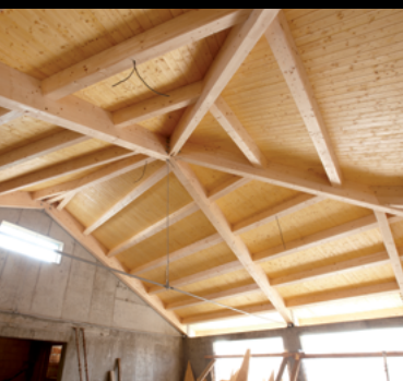
Garáž historických vozidel, Zábřeh
