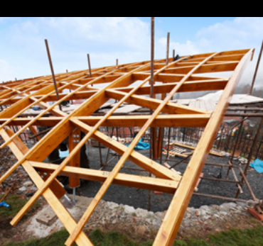
Zastřešení vlničního lisu, Praha
