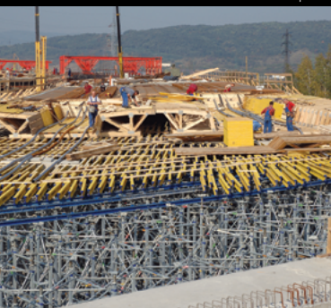
Dálniční most Trmice – Ústí n. Labem
