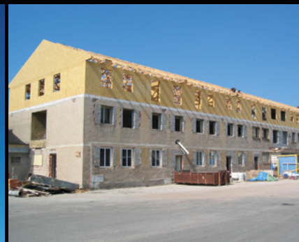
Bytový dům - Jaroměř
