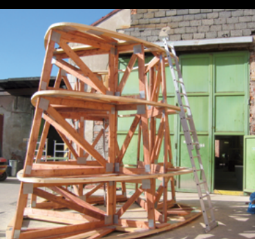
Bednění světlíků – CTP Brno
