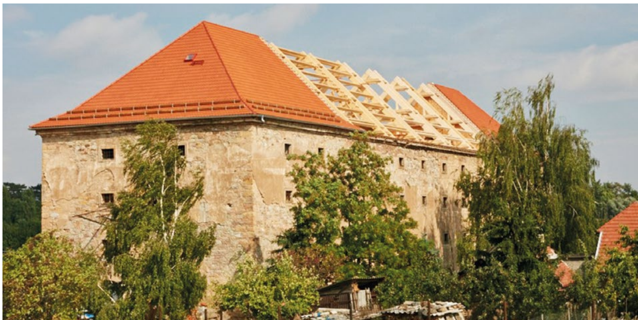
> Rekonstrukce zastřešení barokní sýpky v Břešťanech
