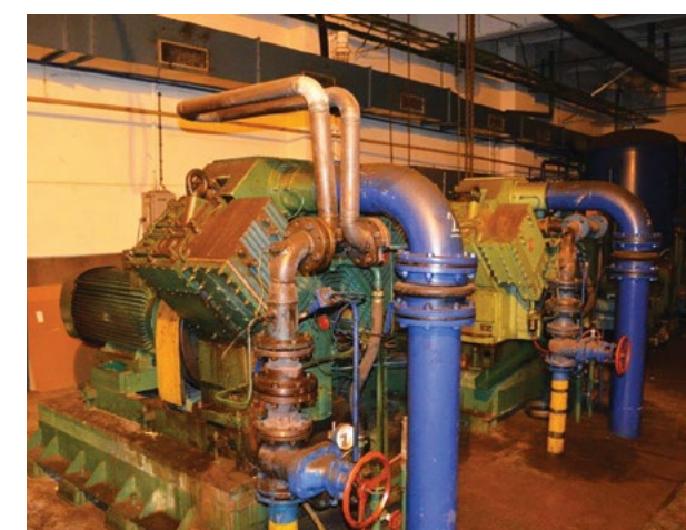
Pro srovnání – původní kompresorovna – pístové kompresory ČKD, odpojeno v dubnu 2015, o dalším osudu technologie ještě jednáme
