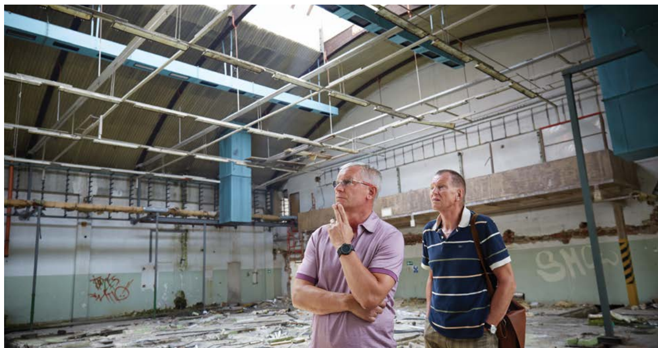
> Architekt Aleš Krčíka s Rudolfem Kasperem při první prohlídce objektu – stav červenec 2014
