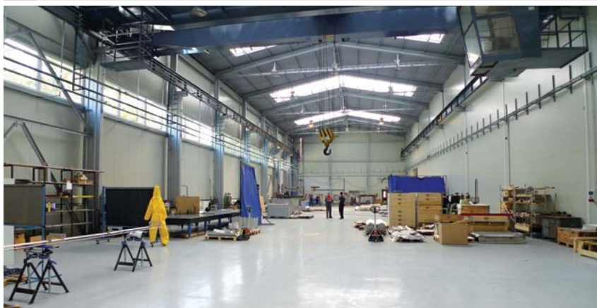
› Hala D po rekonstrukci – stav červenec 2014
