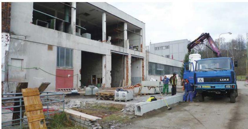
› Rekonstrukce „Přístavba východ“ – lakovna a tryskárna – stav říjen 2014
