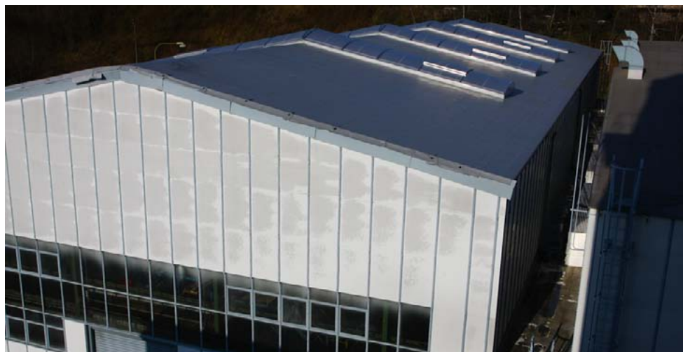
Hala SO 11 – střešní plášť a světlíky po rekonstrukci
