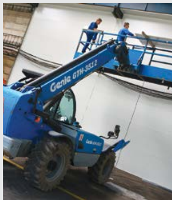
Foto z montáže panelů v provozovně AQUA-STEEL
