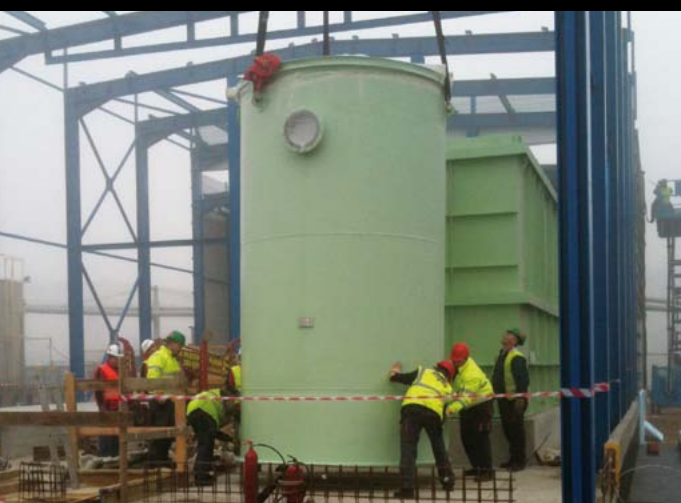
Montáž čířiče a koagulační nádrže Elektrárna Počeradý
