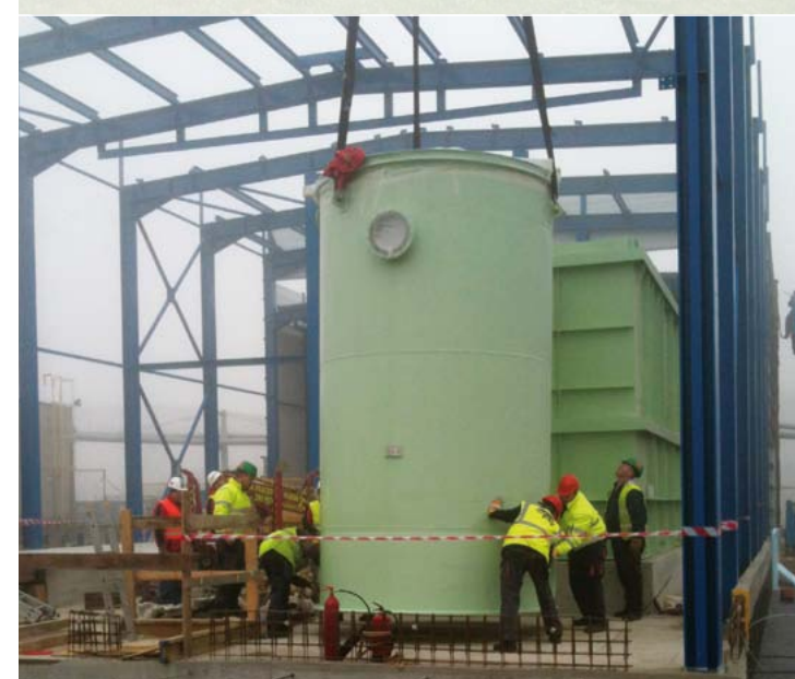
Montáž čiřiče a koagulační nádrže – Elektrárna Počerady
