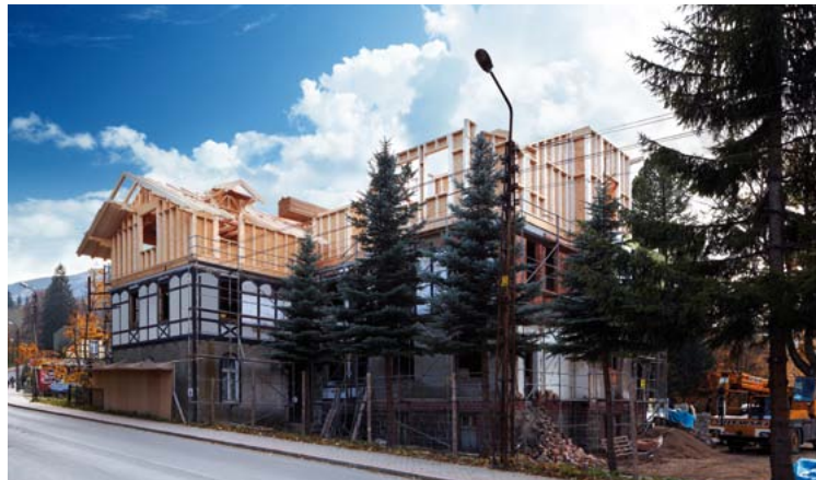
Nástavba hotelu ve Szklarske Porebe celkový pohled z ulice v průběhu montáže
