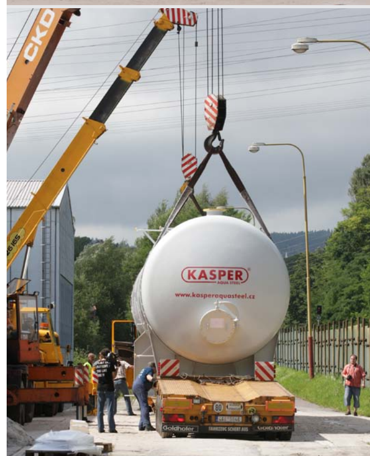
Nakládání a upevnění velkokapacitní nádrže na vodu.
